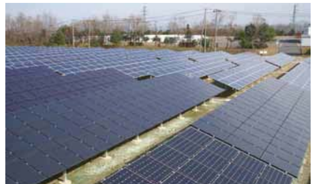
福島県郡山市の産総研福島再生可能エネルギー研究所のソーラーパネル
