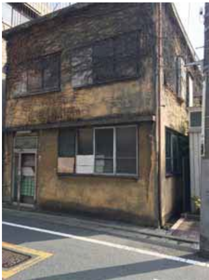
窓は割れ、蔦に覆われた空家
