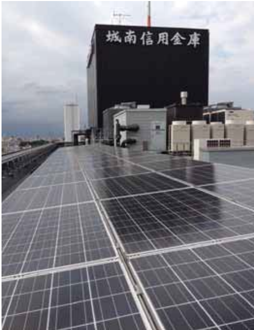
城南信用金庫本店屋上のソーラー発電
